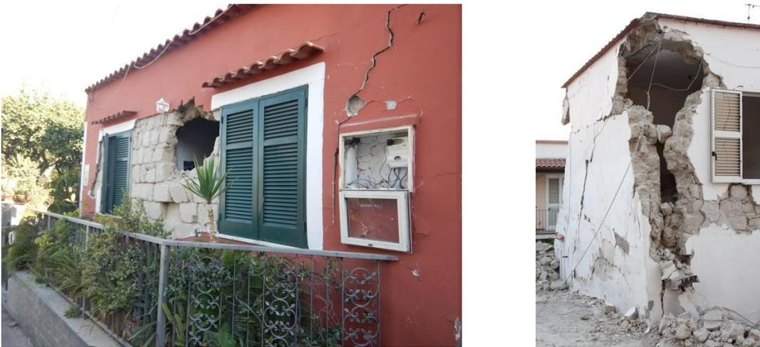
Figura 3.6-2. Casamicciola "Zona Rossa": espulsione di muratura e rottura dell'angolata muraria in edifici di classe B.
