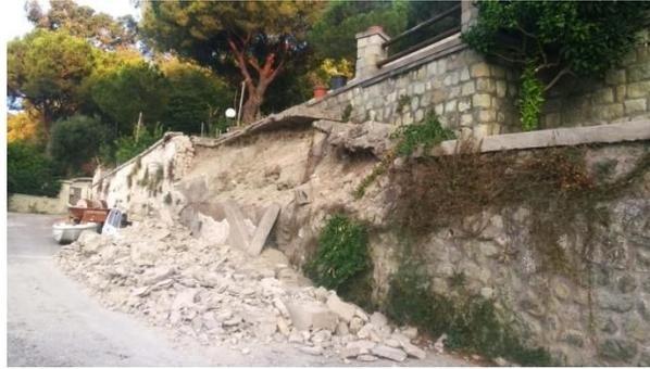
Foto 14. Danni al muro di contenimento e al manufatto.
